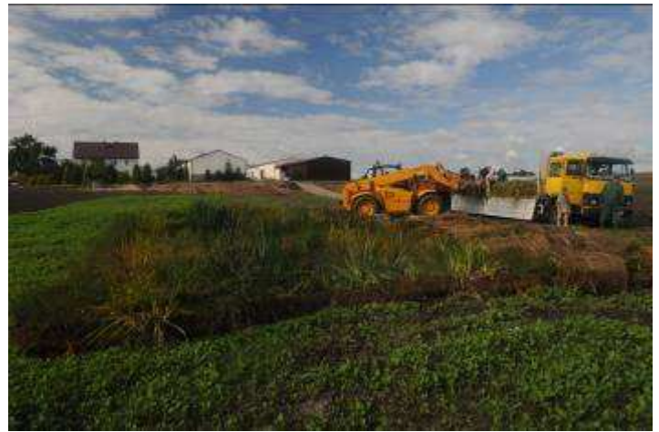
Po przygotowaniu skarpy zbiornika do umocnień następuje transport gotowych wegetacyjnych materiałów.
