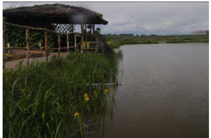
Wykorzystanie do umocnień roślinności brzegowej stanowiącej naturalny falochron i umocnienie.
