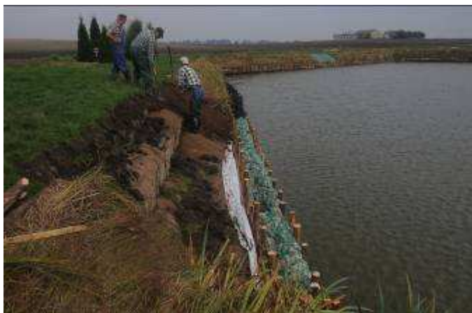
Przy większym narażeniu na erozję, w tym wypadku przez zwiększoną penetrację ludzką stosujemy umocnienia kamienne.
