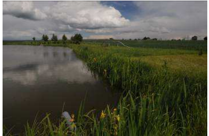
Nasz system umocnień polega na zgodnym z naturą ukształtowaniem brzegu. Łagodny kąt nachylenia skarpy
