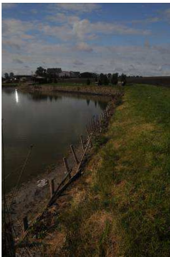
Zerodowany brzeg przez falowanie wody, zimową kre, ryby chodowlane i wędkarzy.
