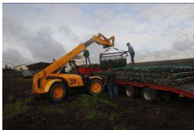
Na miejsce instalacji dowożone zostają gotowe elementy takie jak materace czy walce kamienne.
