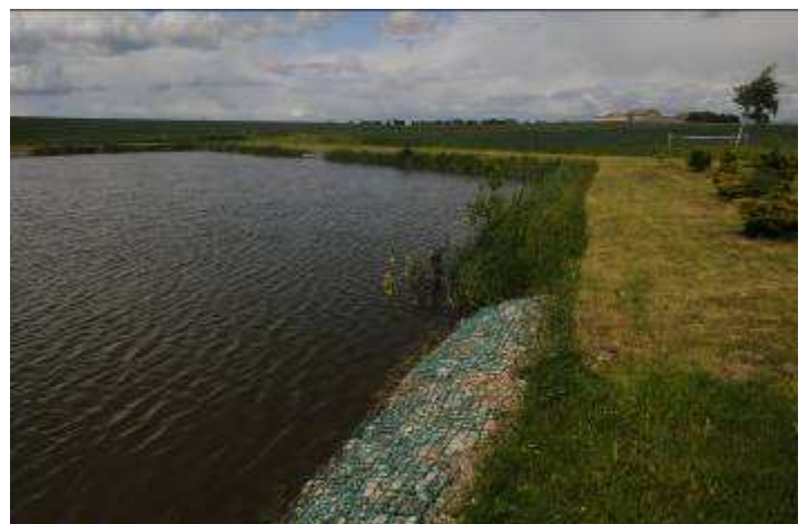
Wyznaczone miejsca dla wędkarzy i rekreacji na zbiorniku umacniamy materiałami kamiennymi.
