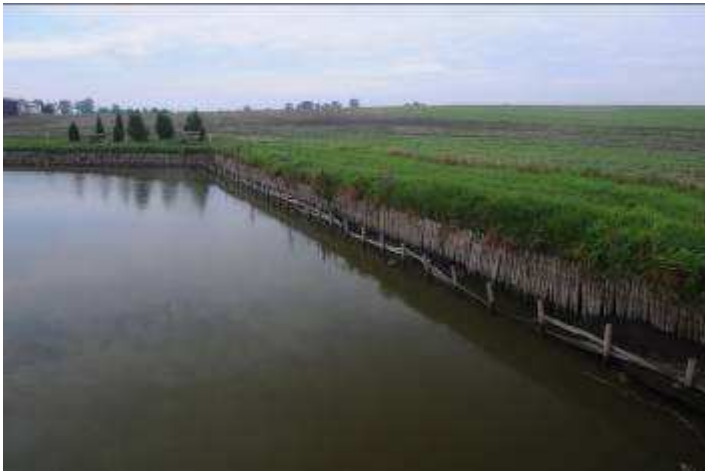
Nawet solidnie wykonana ścianka pionowa z palisady drewnianej zostaje zniszczona na skutek działania wody.
