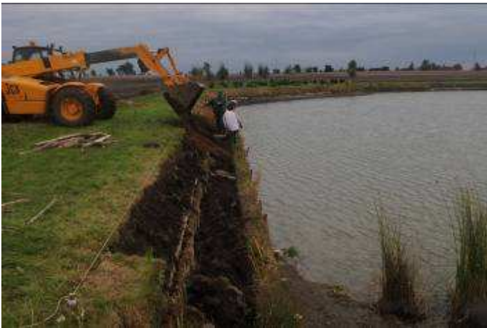
Naprawa zniszczonego brzegu zaczyna się od łagodnego zeskosowania brzegu. Najlepiej pod kątem 1:2.
