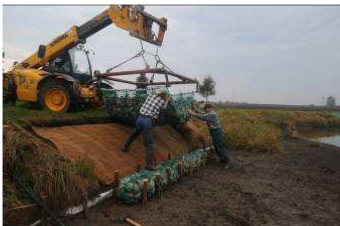
Stopę skarpy zabezpieczamy palisadą z kołków toczonych bitych z dwóch stron co 40cm. a między nimi walec kamienny.
