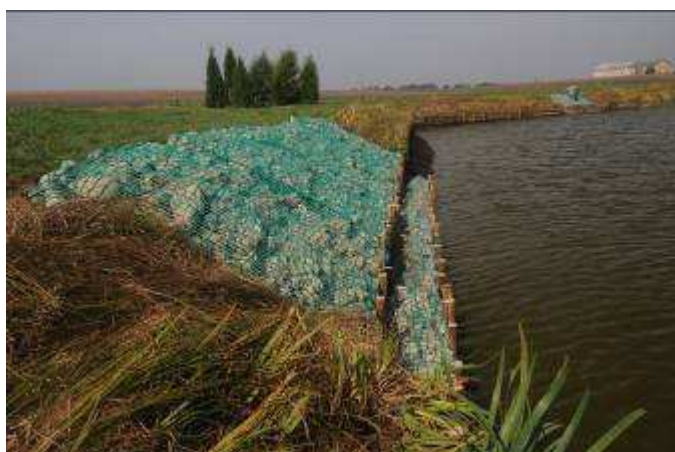
Powyżej walców instalujemy materace kamienne 2x2m, umożliwiające wedkarzom schodzenie do zbiornika.
