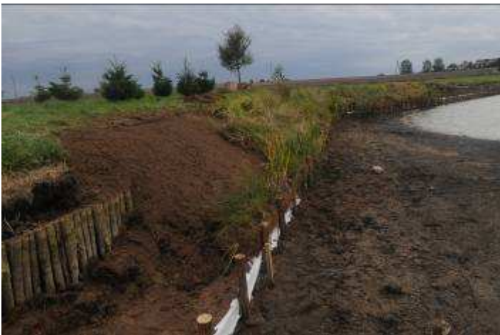
Stopę skarpy zabezpieczamy palisadą z kołków toczonej bitych co 40 cm. Za nią instalujemy wegetacyjną faszynę.
