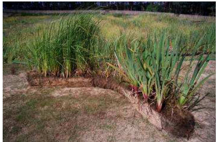
Wegetacyjna faszyna kokosowa obsadzona roślinnością brzegową i przerośnięta przez ich systemy korzeniowe
