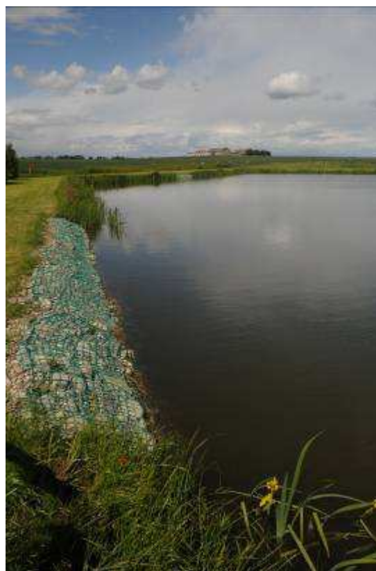
Opaska z wegetacyjnej faszyny i maty kokosowej, oraz walca i materaca kamiennego zabezpiecza brzeg
