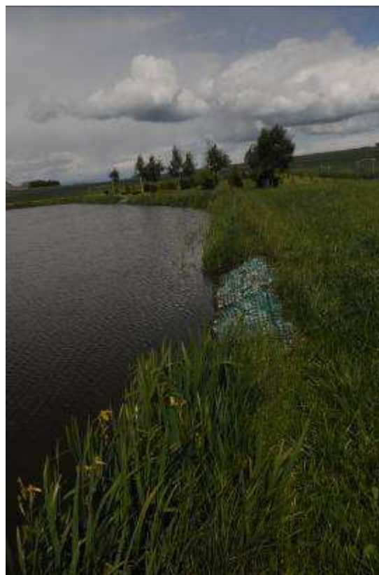
Odbudowany brzeg za pomocą ekologicznych materiałów Bestmann- technik .
