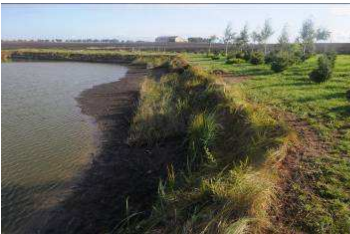
Powyżej faszyny kokosowej układamy wegetacyjne maty kokosowe mocując je do podłoża gwoździami drewnianymi.
